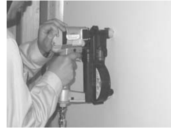
写真 自動ビス打機を両手で押さえたビス打ち作業
