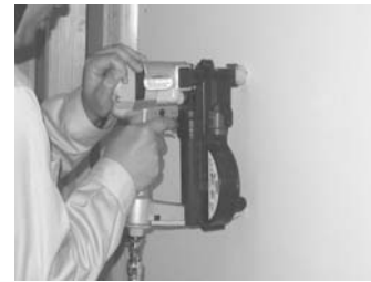
写真 自動ビス打機を両手で押さえたビス打ち作業
