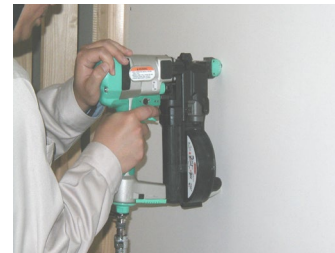
写真 自動ビス打ち機を両手で押さえたビス打ち作業
